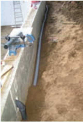
Teich: 2 x d 63 mm-Spaflexschlauch.
